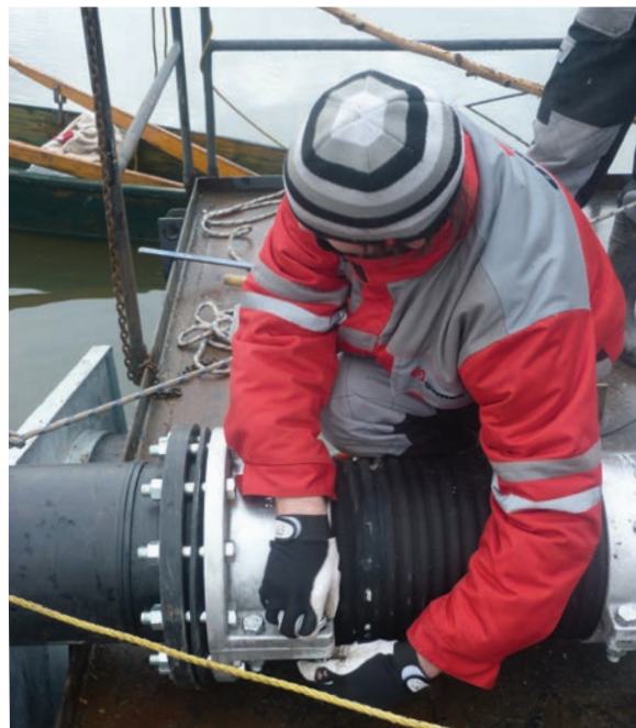
↑ Kontrola pevnosti spoja pred spustením čerpadla
